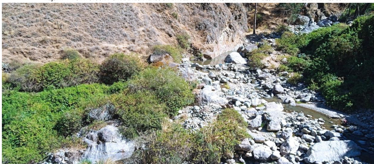
Imagen N° 2. VISTA FOTOGRAFICA DEL TRAMO A INTERVENIR, OBSERVE LA ACCION EROSIVA EN LA MARGEN IZQUIERDA DE LA QUEBRADA QUISUAR
